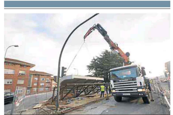
Una grúa coloca la estructura soporte de la marquesina. ■ MARIETA
